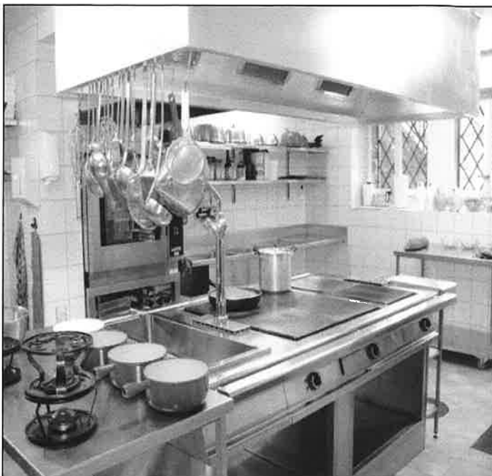
La nouvelle cuisine, plus fonctionnelle et conforme aux normes de sécurité et d'hygiène
