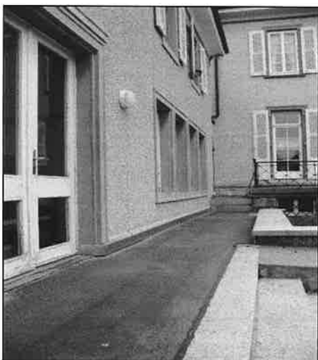
L'étanchéité des murs du sou-sol est refaite aux deux ailes du bâtiment
