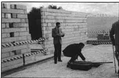
Un document est posé dans la dalle
