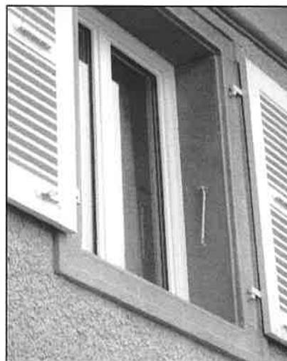
Les fenêtres isolantes et plus étanches aident à économiser le mazout
